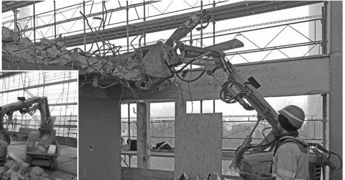
Démolition par croquage.
